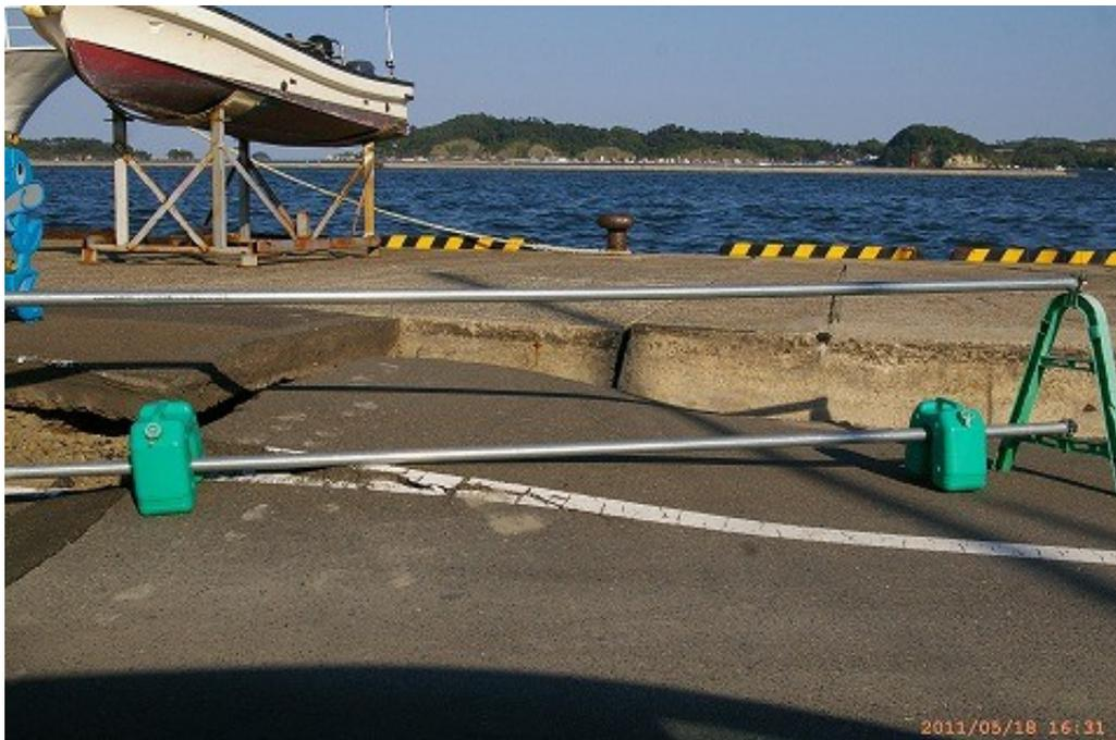
塩竈市魚市場周辺岸壁 アスファルトが沈下し50センチほどの段差ができています
